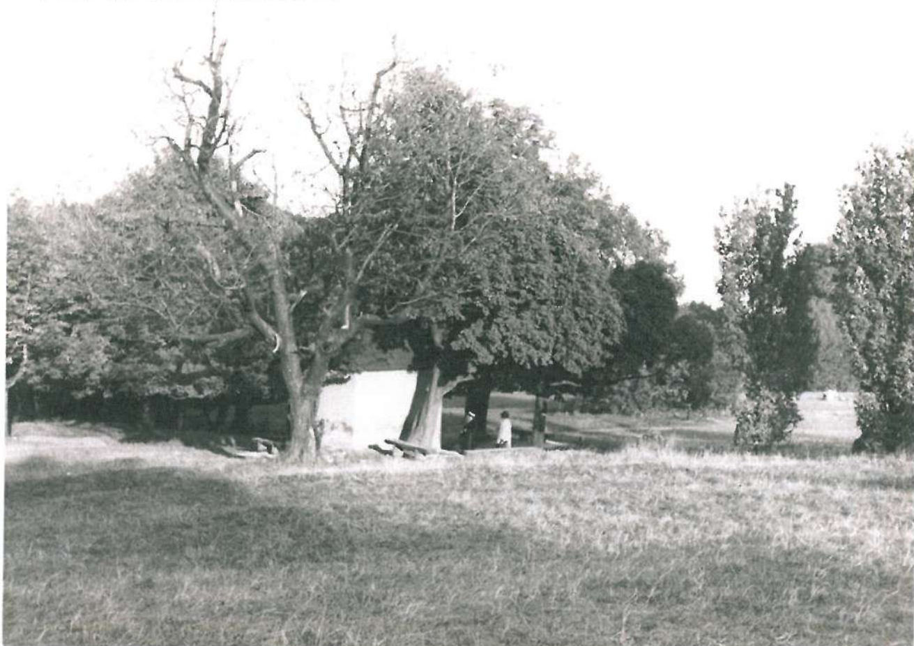
4.4.kép: az 1941-ben készült (FszEK) képen látható kápolna, azonos a 4.3.képen és a NATÁLIA NŐVÉR I. Kötetében, a 228. oldalon található 1923(8?)-as kép kápolnájával. (Hosszúsága 2.5-3m, magassága 4-5m.) Az 1931-es állapothoz képest itt támfal épült a domboldal felől.
